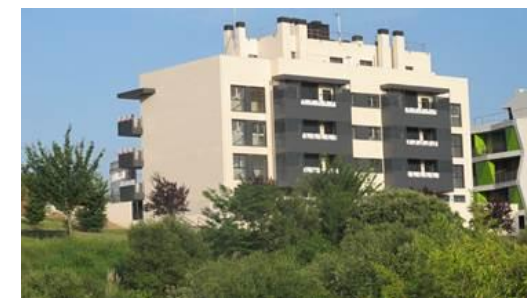
Construcción en progreso
